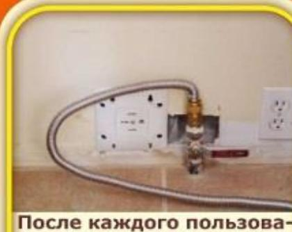
**После каждого пользования газовой плитой закрывайте краны** на плите и на вводящей трубе.
